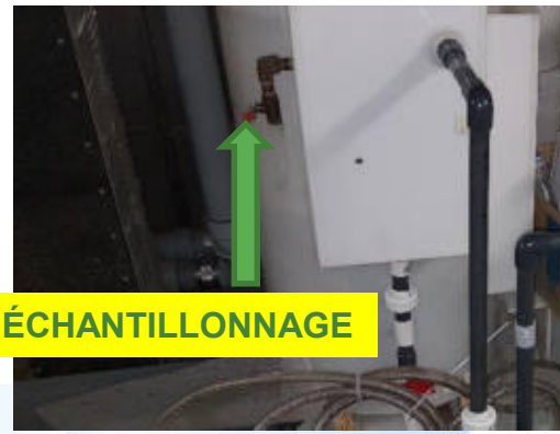
À la sortie de l'unité électrochimique EC/ER
